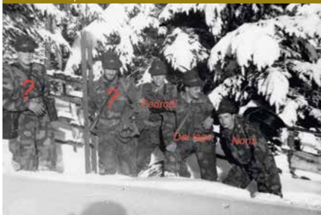
Manovre della compagnia Comando a Monguefio, btg. Trento, 6 a cp., nel dicembre 1965: squadra per la stesa dei cavi telefonici nella zona Monte Cucco-Val Pusteria. Contattare Piergiorgio Noris, 329/0097803.
